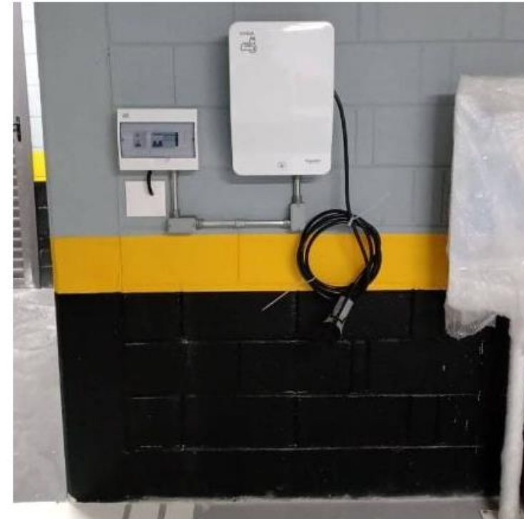
Exemplo de ponto de recarga para veículo elétrico em garagem de edifício em São Paulo (Condomínio Luminus Jardins)
