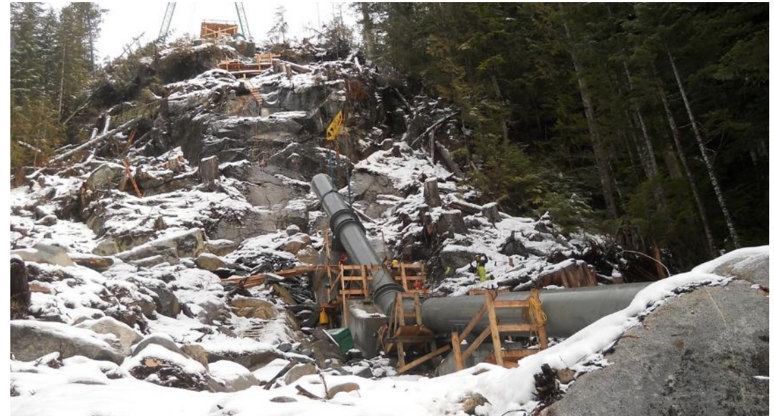
Assentamento do tubo e soldagem, em terreno acidentado e condições adversas
