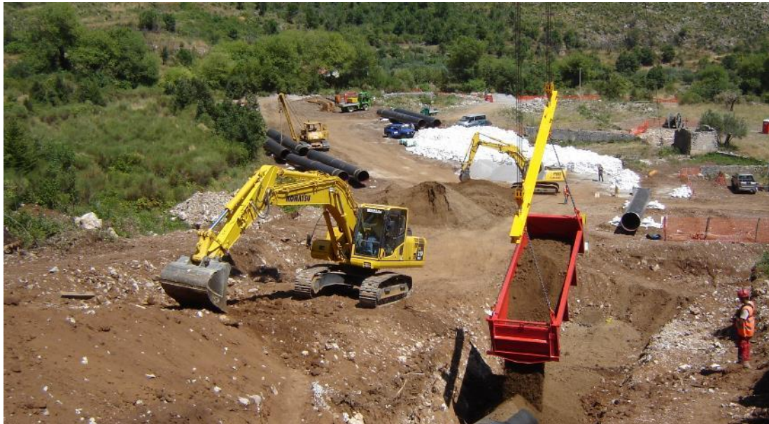
Transporte de material pétreo até o local de aplicação
