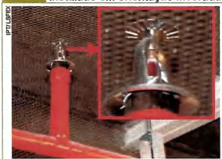
Foto 9 Chuveiro automático com presença de produtos de corrosão
