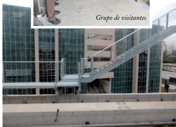
Instalações do pátio Oratório
