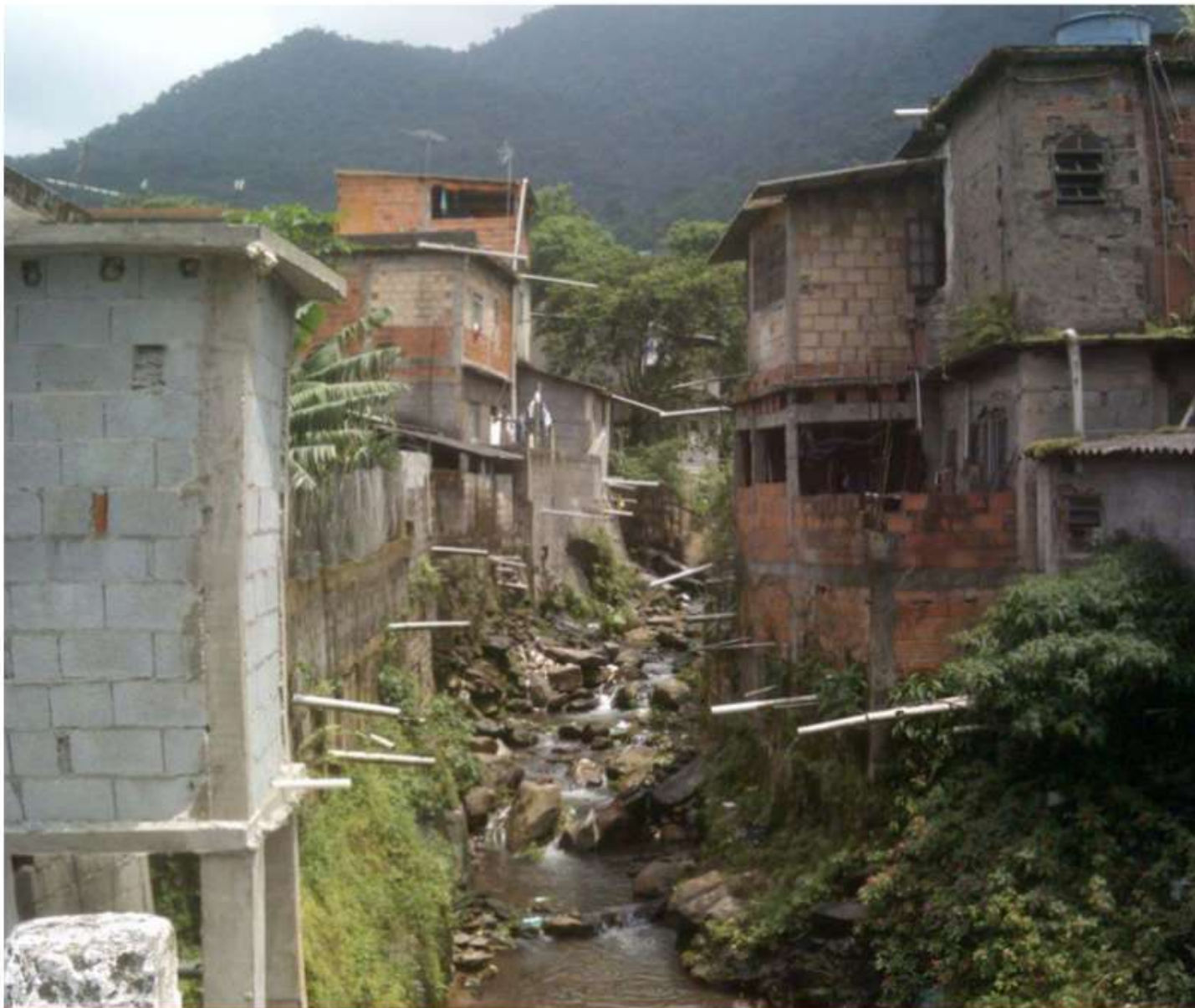
Despejo de água servida sobre o córrego
