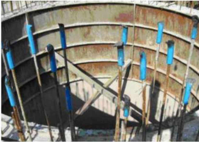
Vista externa da Obra em Cubatão
