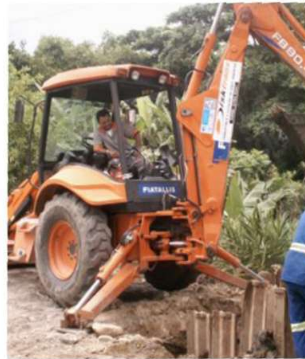
Abertura de Vala em Cubatão
