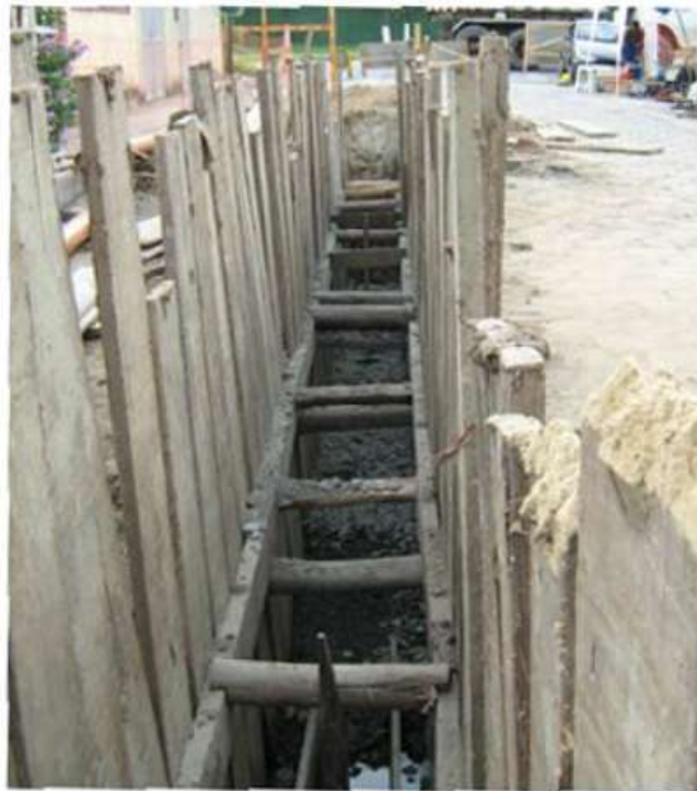
Vista externa da Obra em Cubatão
