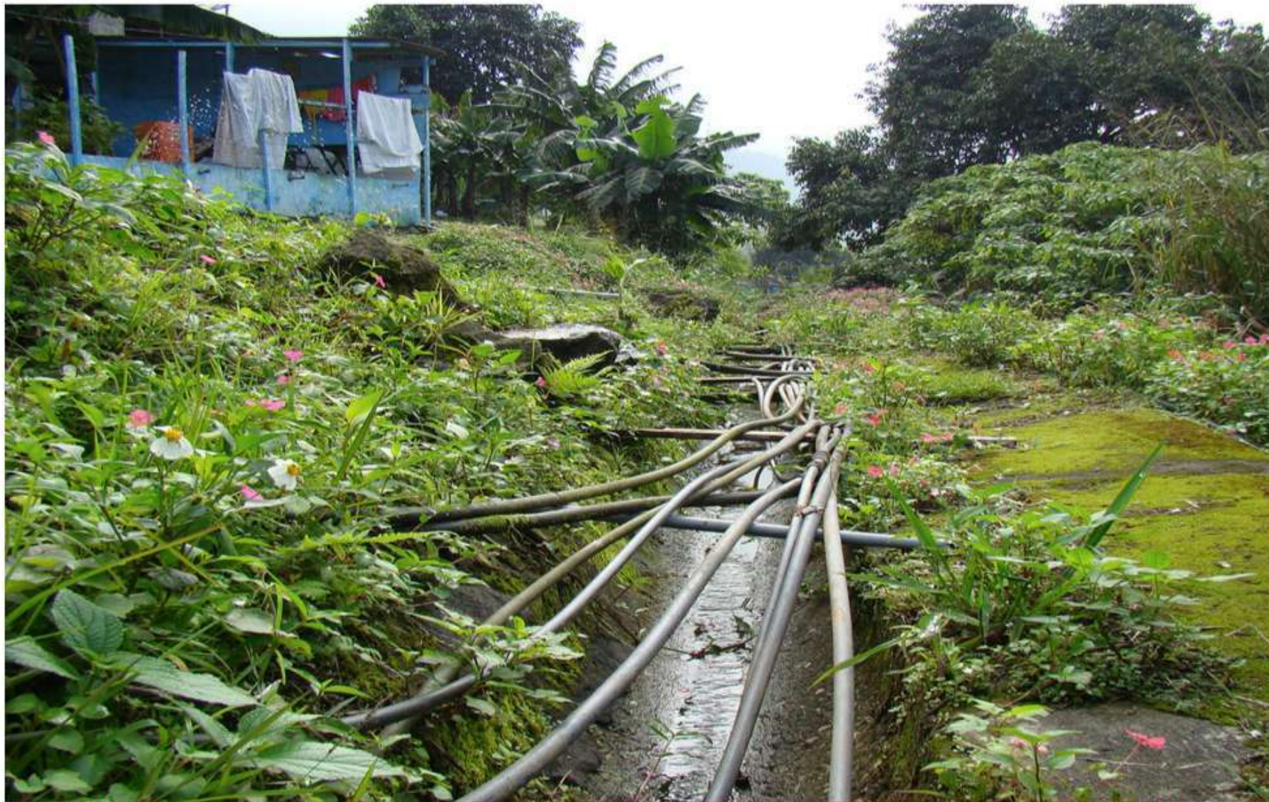
Atual abastecimento de água
