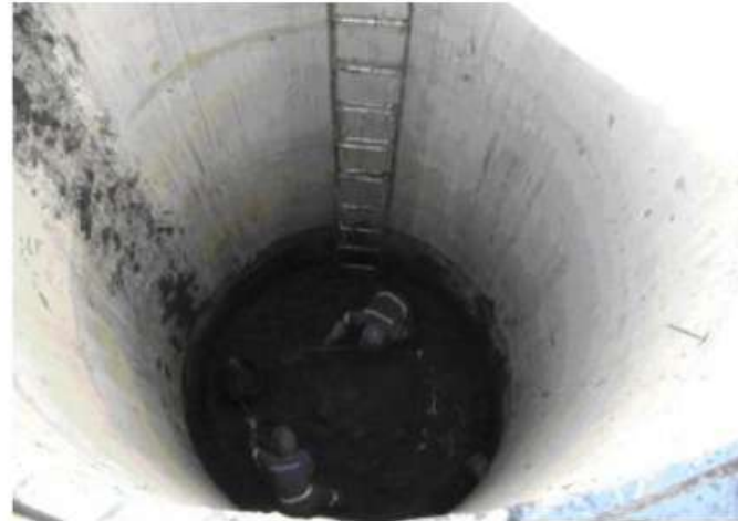
Equipe de Trabalho no interior da Obra em Cubatão
