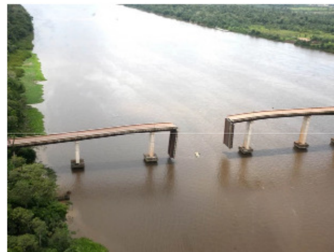
Uma das embarcações que fazem a travessia para o município se chocou com o pilar da ponte do rio Moju. Em um acidente semelhante, ocorrido em março, a ponte ficou intransitável (Foto: Antônio Silva/Ag. Pará)
