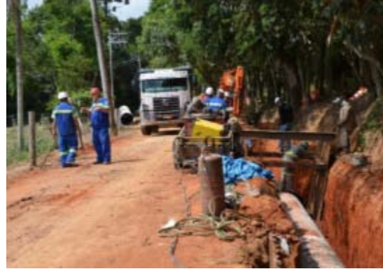
Intervenções no Córrego Guaratuba para incremento de 1,0 m 3 /s
