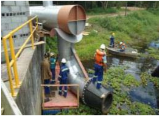
Ampliação da EEAB Biritiba Mirim em 3,0 m 3 /s
